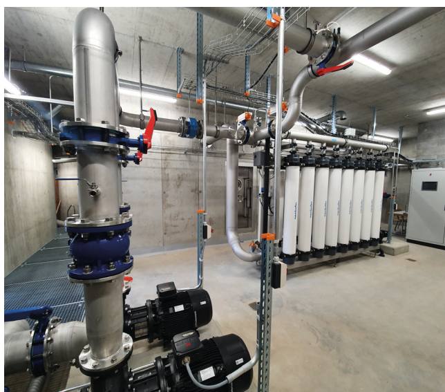
La Commune investit pour assurer la qualité et sécuriser l'alimentation en eau de la population. À Morgins, le réservoir du Géant a été agrandi et un système d'ultrafiltration installé.
