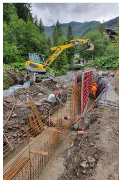
Les travaux de sécurisation de la Vièze se sont achevés en 2022. L'an dernier, la Commune a investi CHF 280'000.-.
