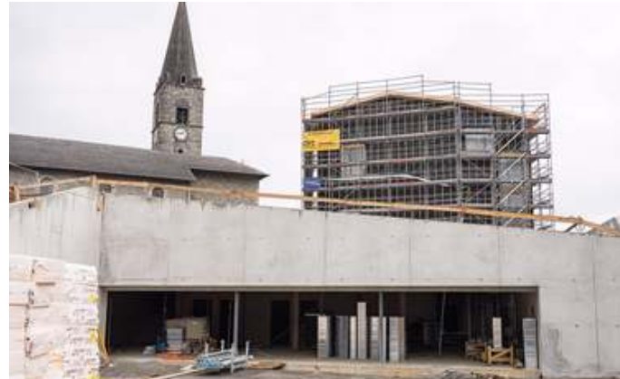
Vue depuis la cour avec, au sous-sol, les futures salles multi-usages.
