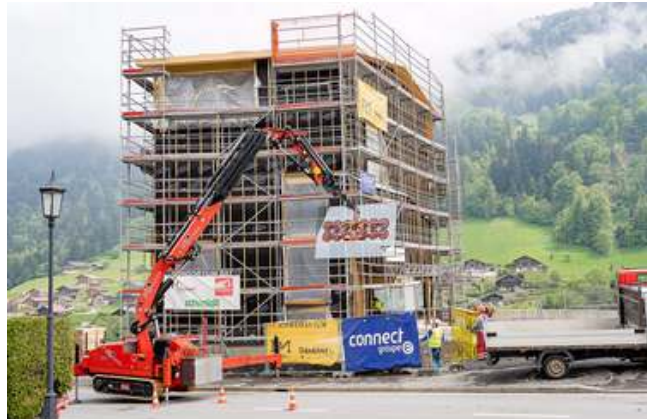
Pose des fenêtres, mercredi 13 mai 2020.
