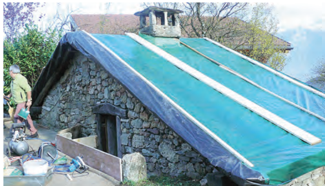
Murs fissurés, toit cassé, le four à pain de Propéraz a besoin d'importants travaux de restauration.
